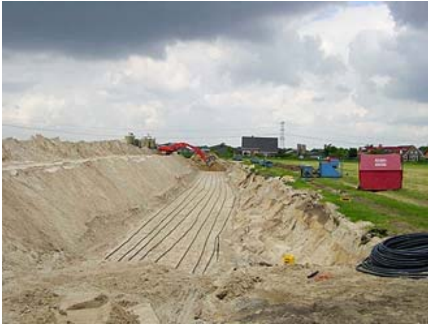
Fig 9.1: Aanleg van een horizontale warmtewisselaar in de bodem
