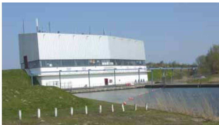
Gemaal Blocq van Kuffeler, Almere (meetpunt 00008)
