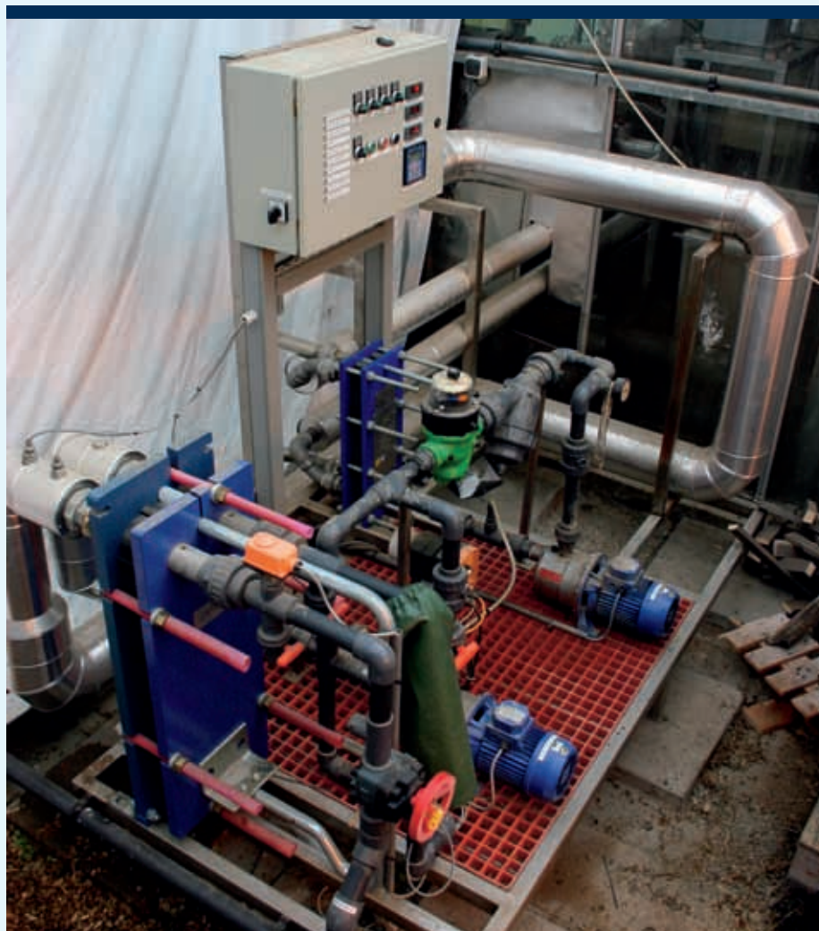
Van der Velden verhit het drainwater door dit via een warmtewisselaar langs het hete water van de warmtebuffer te leiden.
