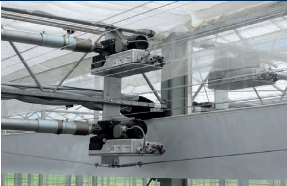
Met geïntegreerde intelligentie en 'busbesturing' is het instellen van een kier in het scherm heel nauwkeurig te regelen.
