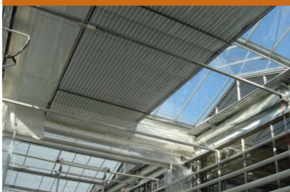
Rechtsboven het zonwerende scherm (helemaal geopend), op dezelfde hoogte (half gesloten) het lichtwerende scherm met daaronder het energiescherm (een klein stukje dichtgelopen).
