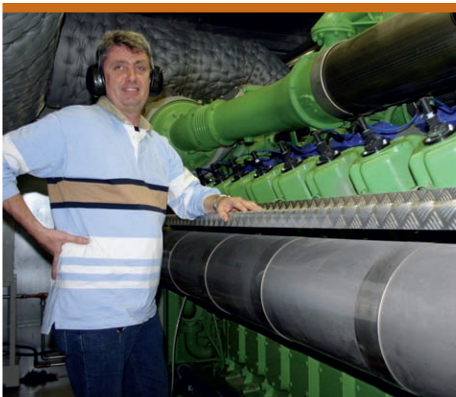
Voor het verwarmen van de kassen gebruikt Ammerlaan warmte van een eigen warmte/krachtinstallatie. De opgewekte elektriciteit gaat het elektriciteitsnet in, omdat hij geen belichting heeft.
