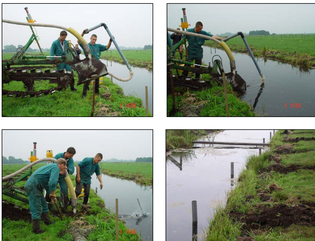
Figuur 5.40. Installatie van draaibare PVC eindbuizen (zogenaamde knietjes) op 60-mm draineerbuizen, in het veenweidegebied van Proefboerderij Zeggeld van Wageningen UR, in 2004. Hiermee kunnen drains naar wens 'in- en uitgeschakeld' worden (foto's: Lodewijk Stuyt).
