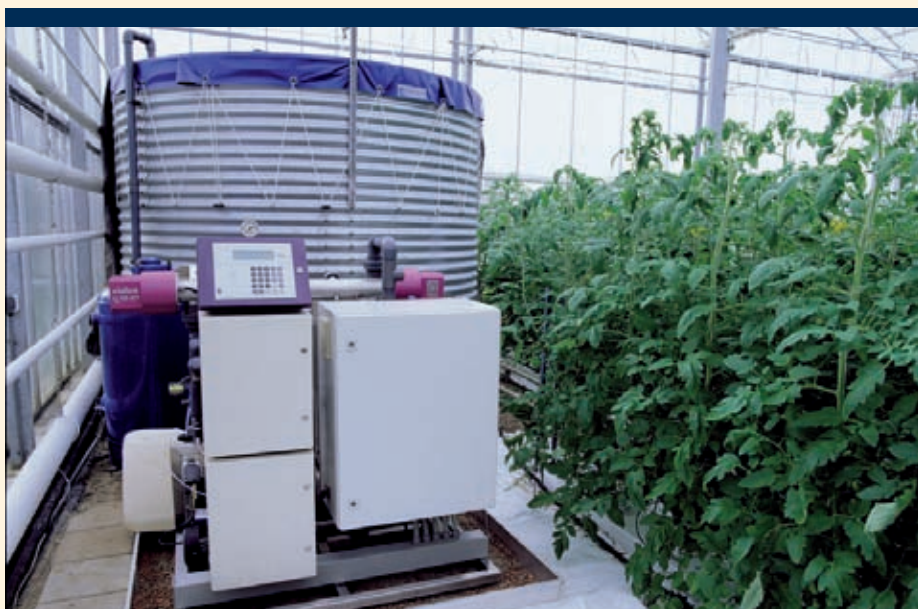
De Vialux meet continu de T10-transmissiewaarde van het water (het percentage UVC-licht dat na 10 mm waterlaag nog over is) en past daarop de doorstroming en het vermogen van de lamp aan.
