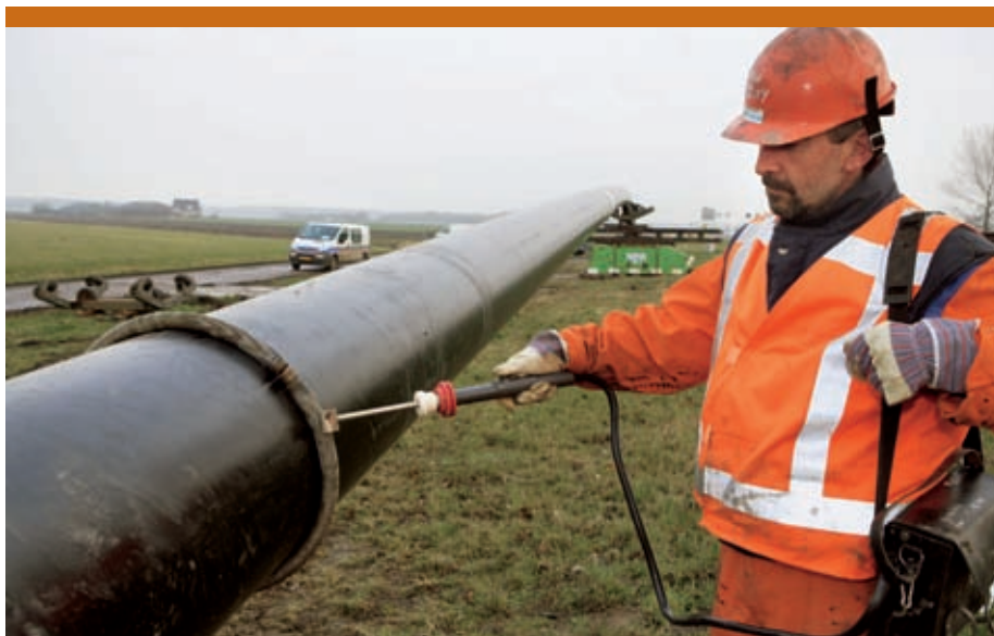
In het afgelopen jaar is een uitgebreid leidingennet aangelegd zodat inmiddels ruim vierhonderd ondernemers in het Westland en de B-Driehoek CO 2 van OCAP gebruiken.
