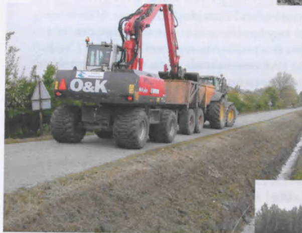
Baggerwerk in uitvoering. De bagger wordt direct op een kar geladen en naar een perceel afgevoerd.
