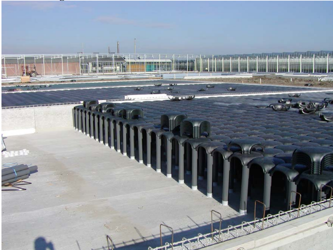
Figuur 1 Bouw Watershell® kelder door Waterblock BV
