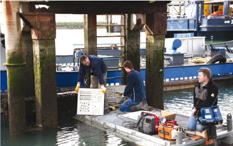
In de betonplaten is al enige ervaring verwerkt uit experimenten bij de pieren van IJmuiden.
