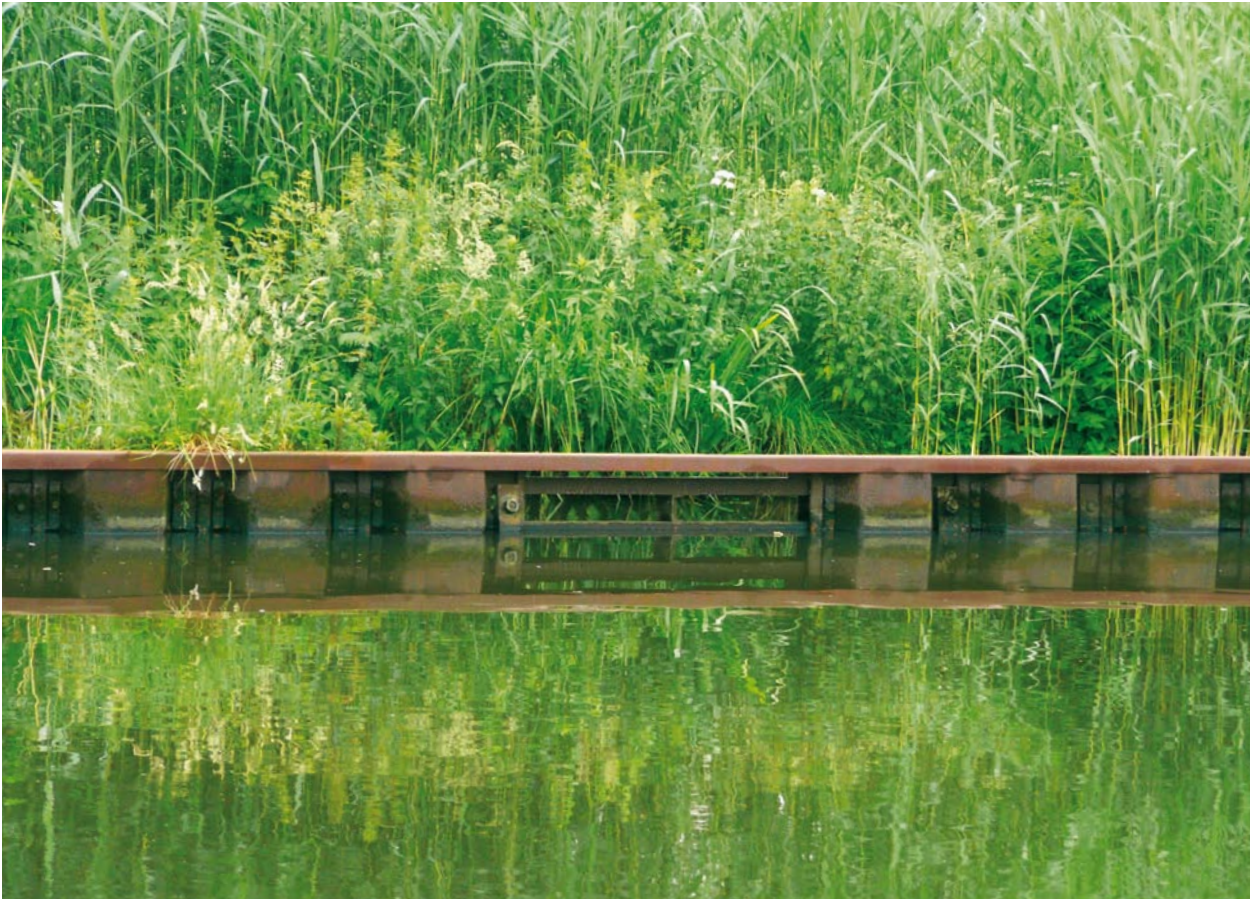
Door openingen in de damwand worden natuurvriendelijke oevers bereikbaar voor vis.
