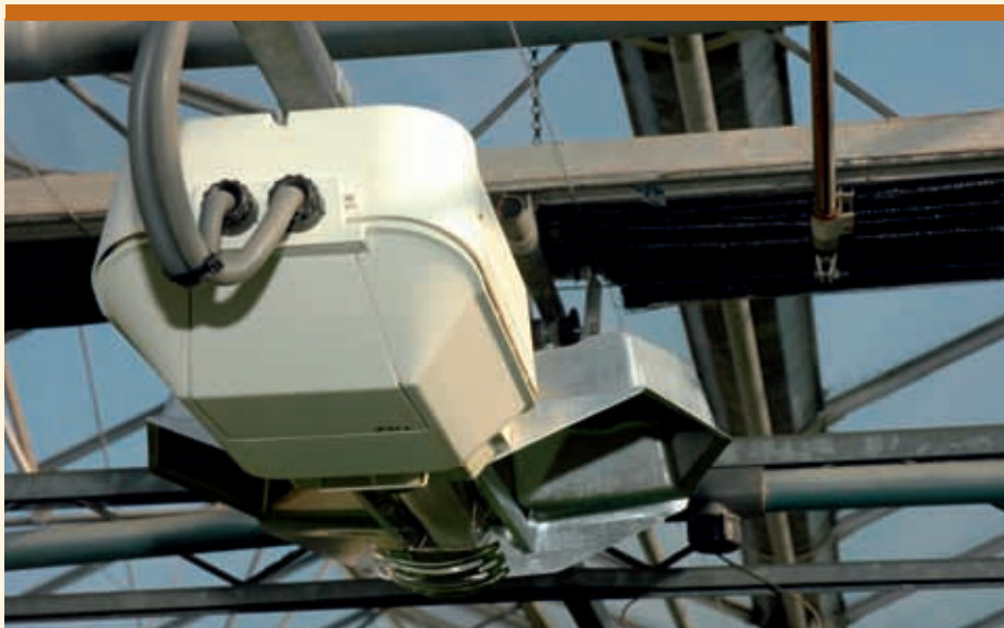
Kunststof armaturen met een klasse A-aanduiding gaan wel twintig jaar mee, mits niet alleen de condensatoren tijdig worden vervangen, maar ook de reflectoren en de bol.
