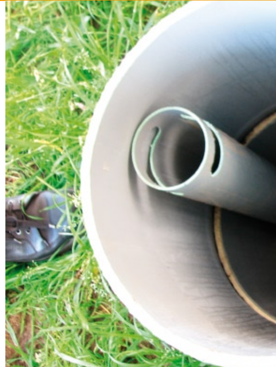
Peilgestuurde drainage met put en pijpje
