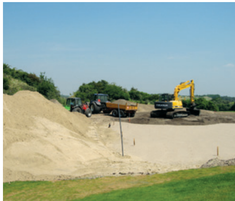
De ondergrond is het oorspronkelijke duinzand. In plaats van klei heeft die nu een toplaag van 25 centimeter zand met daar nog een keer 25 centimeter zand gemengd met heide compost.
