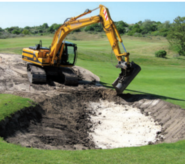
Renovatie betekende op de Haagsche ook dat enkele bunkers werden gewijzigd. Ook zijn er enkele veranderd en aangepast.
