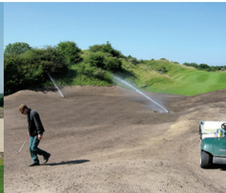
Waar het allemaal om te doen is. Na het inzaaien is met de hark de laatste hand gelegd aan de green. De beregeningsinstallatie werd aangepast en uitgebreid waar nodig door Bas van Oosterhout. Vanaf nu moet de natuur het even zelf doen. Daarna weer de taak aan de greenkeeper om het allemaal te houden zoals het bedoeld is.
