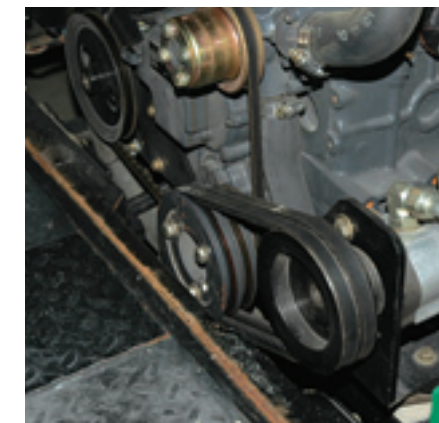
Door een stuk uit het chassis te slijpen – en ook weer dicht te maken – ontstaat ruimte om een dubbele poelie te monteren. Daarmee verdubbelt de aandrijfkracht en die blijkt dan ruim voldoende voor het zwaarste werk.
