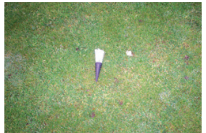
Een praktische oplossing is om met een markeringsstof kunstgras in het maaienveld een ondergrondse drainageput te markeren.
