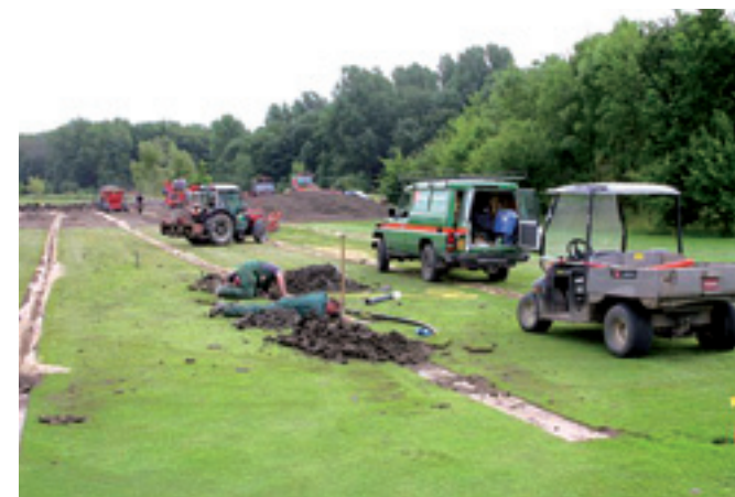
Het beste moment om een kaart van de baan te maken, is al tijdens de aanleg, wanneer nieuwe drainage en beregening nog bloot liggen.
