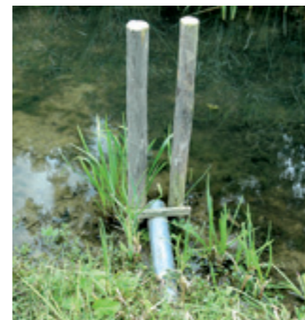
Een centrale, dikke pvc-pijp die het water van meerdere drains naar de sloot afvoert, is voor het onderhoud van slootkanten ook veel handiger dan een groot aantal drains die direct op de sloot afvoeren.
