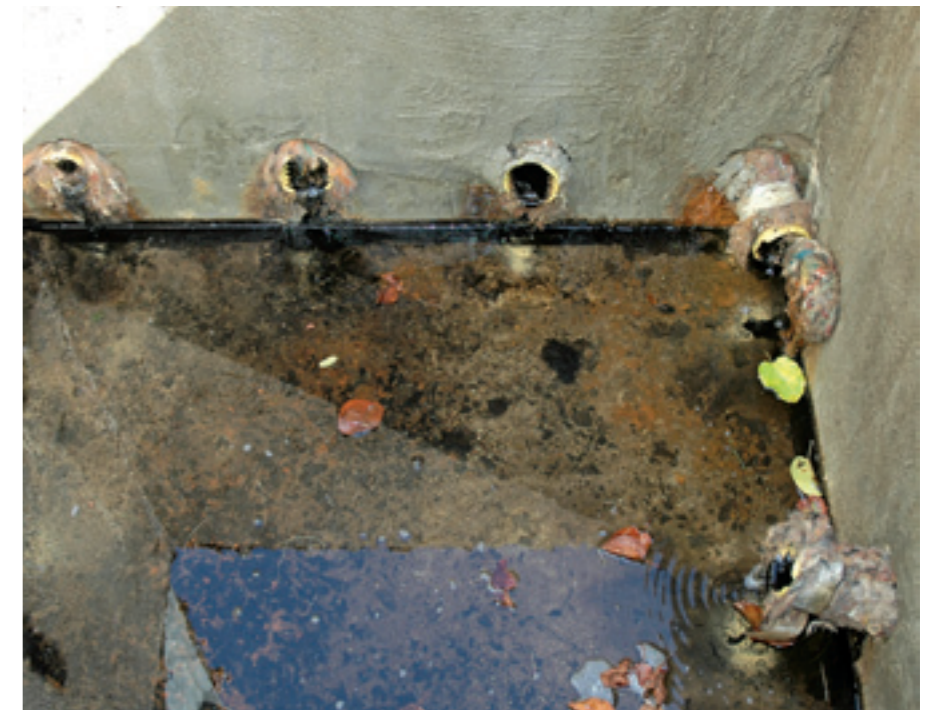
Als de drainages uitkomen in een centrale put dan zijn ze gemakkelijk door te spuiten. Een kleiner aantal uitlopen naar de sloot maakt het ook gemakkelijker de drainages optimaal te laten functioneren.
