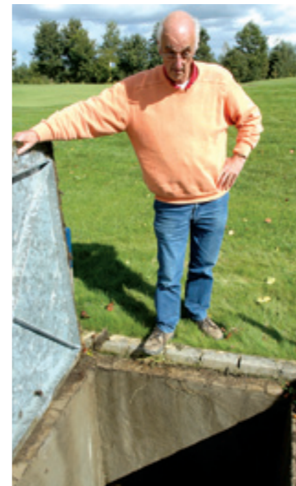
Als de drainages uitkomen in een centrale put dan zijn ze gemakkelijk door te spuiten. Een kleiner aantal uitlopen naar de sloot maakt het ook gemakkelijker de drainages optimaal te laten functioneren.
