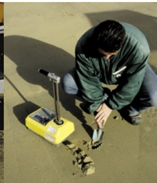
Trisoplast oogt net als zand en zeker als er eenmaal water in de vijver staat, is niet meer na te gaan of de leverancier de klus volgens het bestek heeft geklaard. Daarom wordt bij de aanleg steeds door een extern bureau steekproefsgewijs gemeten of de laagdikte en de verdichtingsgraad kloppen en wordt de samenstelling van de Trisoplast gecontroleerd.
