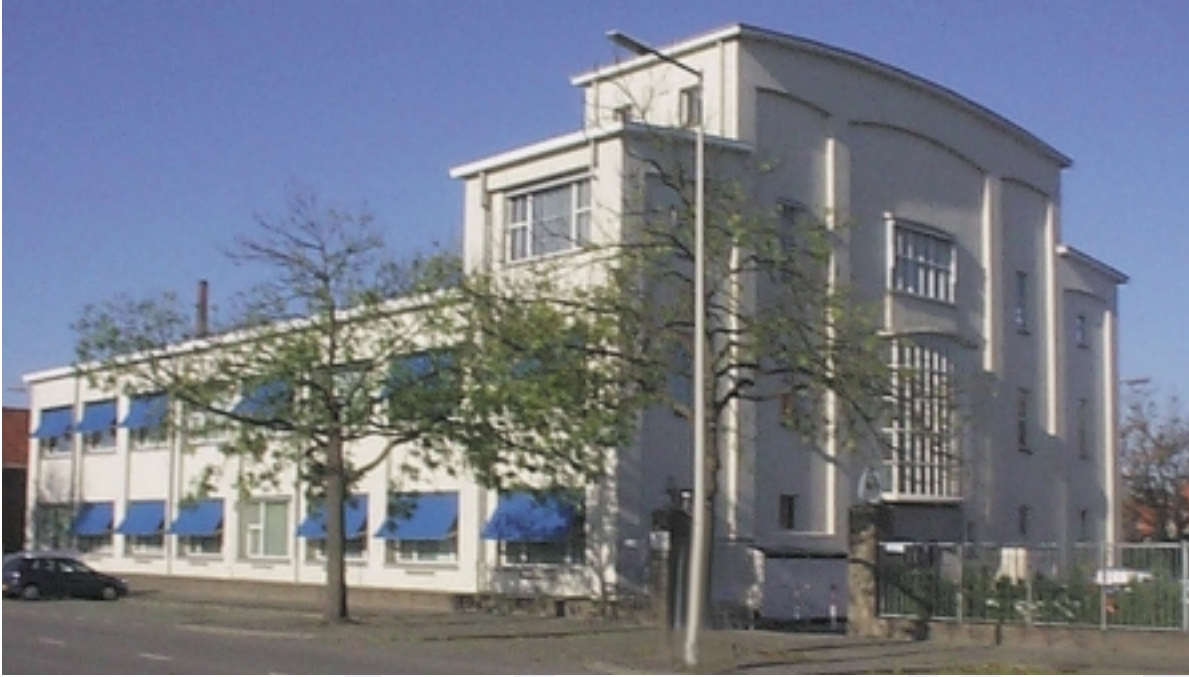
Het IRS is gehuisvest in een voormalig suikermagazijn in Bergen op Zoom
