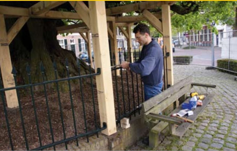
De nieuwe leiconstructie met ingepast 19de-eeuws hekwerk.
