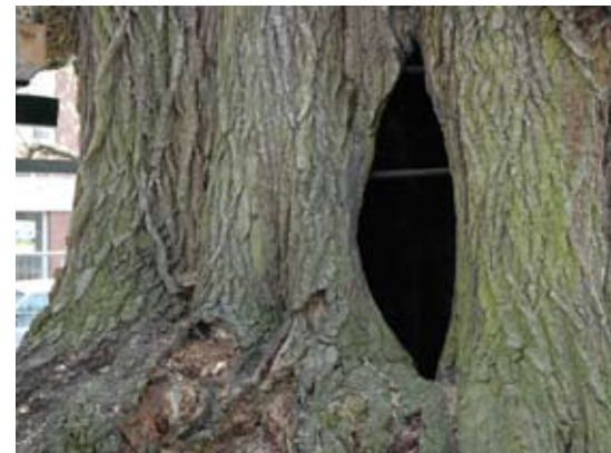
In de jaren tachtig hebben boomchirurgen de binnenkant van de holle boom schoongefreesd en stangen geplaatst. Hierdoor kon de tondelzwam zich manifesteren.
