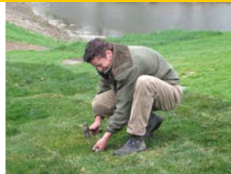
Stijn Wesselink spijkert met lange U-vormige spijkers de graszoden vast op de schuine hellingen.
