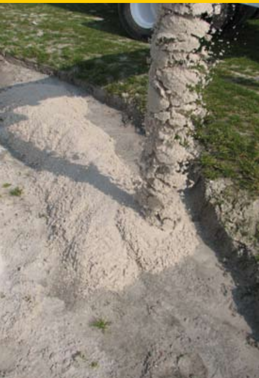
Nauwkeurig het zand aanvullen tot de in de klei uitgestoken rand.
