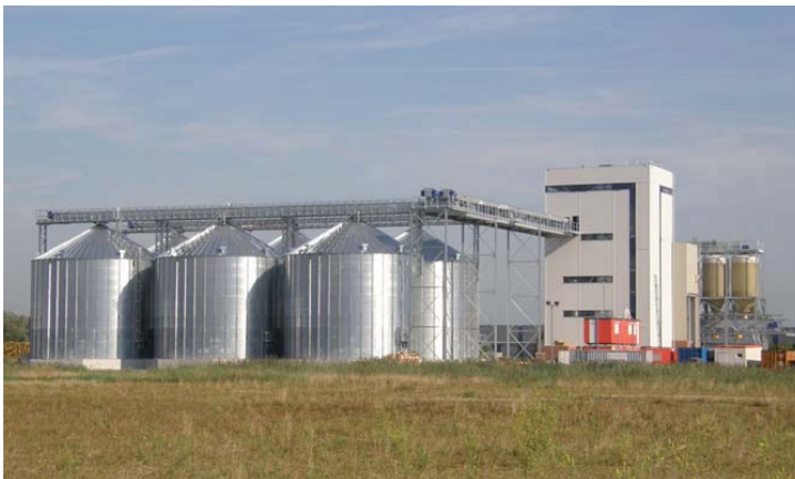
Het op- en overslagbedrijf van Boerenbond Deurne in Oss.
