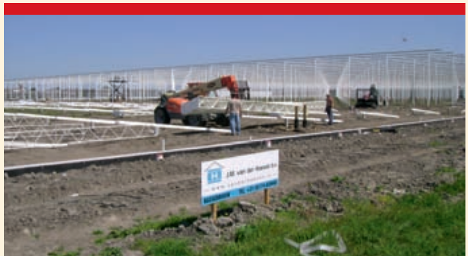
Het nieuwe bedrijf van Van der Wel in aanbouw.
