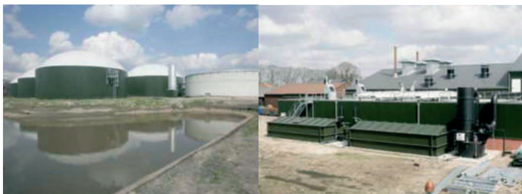
Figuur 1. Voorbeeld co-vergistingsinstallatie. Deze installatie bevindt zich in Salland en heeft ongeveer de helft van de capaciteit van de geplande installatie in Aalten.
