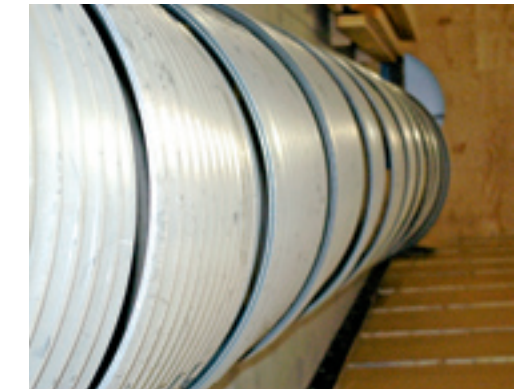
▲ Bovengrondse kanalen nemen ruimte in, waardoor de opslag 5 à 10 procent groter moet zijn.
