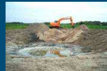
nieuw gegraven stilstaande wateren
