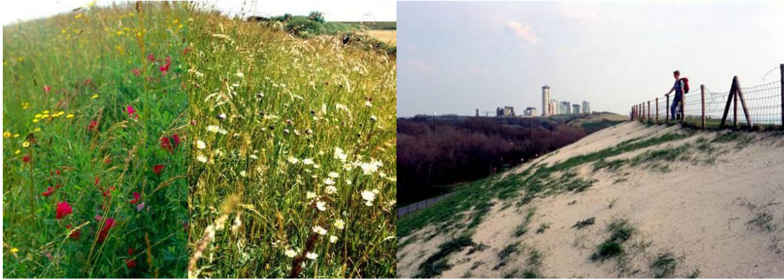
Afbeelding 3.9 en 3.10. Links: bloemdijken; rechts: Nolledijk ten westen van Vlissingen met opstuivend zand. (foto's Joep Frissel)
