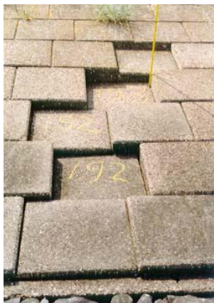
Afbeelding 3.4. Verzakking steenbekleding (bron: VTV)
