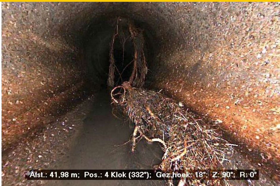
Een mogelijk probleemgeval: wortels groeien in het riool.
