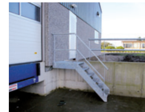
Handig is een trap aan het einde van de laadkuil met een loopdeur ernaast voor de chauffeur.
