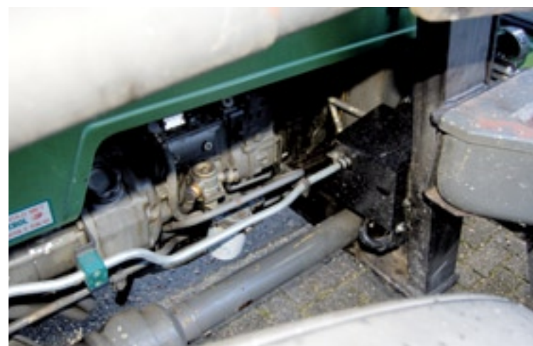
▲ Reduceereenheid tussen vliegwielhuis en aankoppeling voorlader met manometer en transportleiding.
