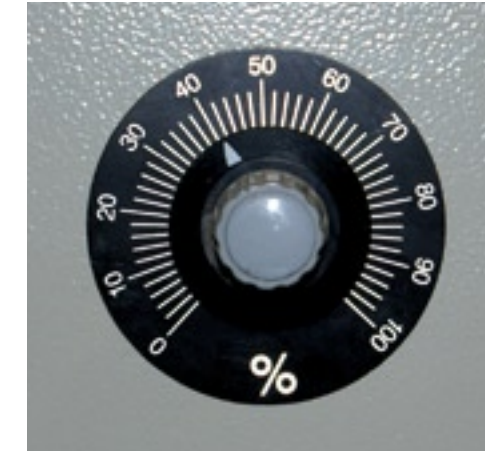
▲ Een ventilator mag niet te ver worden terugtoerd.
