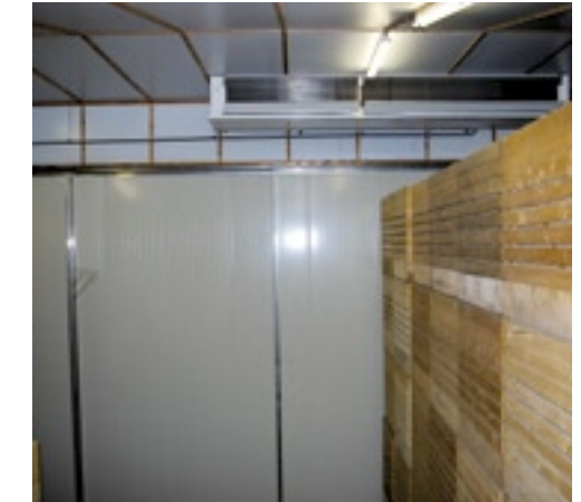
▲ In een cel met mechanische koeling is een toerengeregelde ventilator zeer rendabel.
