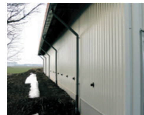
Onder iedere ventilator komt een gasbuisje.
