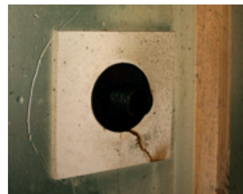
Een kant-en-klare gasbuis kan zo door de constructie geschroefd worden.
