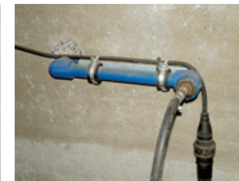
Om buiten of in een andere loods lucht te hebben, kan je een gat in de muur boren, een leiding erdoor stoppen en een koppeling hierop monteren.
