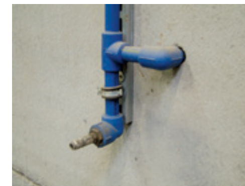
Om buiten of in een andere loods lucht te hebben, kan je een gat in de muur boren, een leiding erdoor stoppen en een koppeling hierop monteren.
