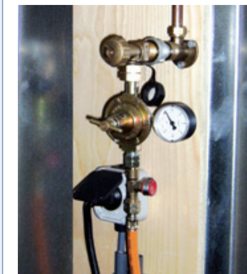
Zorg dat de aansluiting los gehaald kan worden. Je kunt de kachel dan op meer plaatsen gebruiken.
