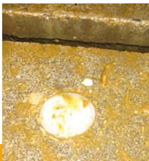
Een van de sensoren die in de roostervloerelementen zijn gelijk. Ze laten de robot weten waar hij precies is.
