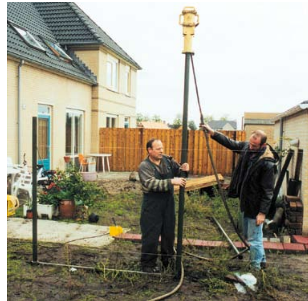
Een pneumatische rammer is een uitkomst op moeilijk bereikbare plekken. Ook is de slagkracht groter dan de drukkracht van een kraan of trekker, zeker bij een hardhouten paal.
