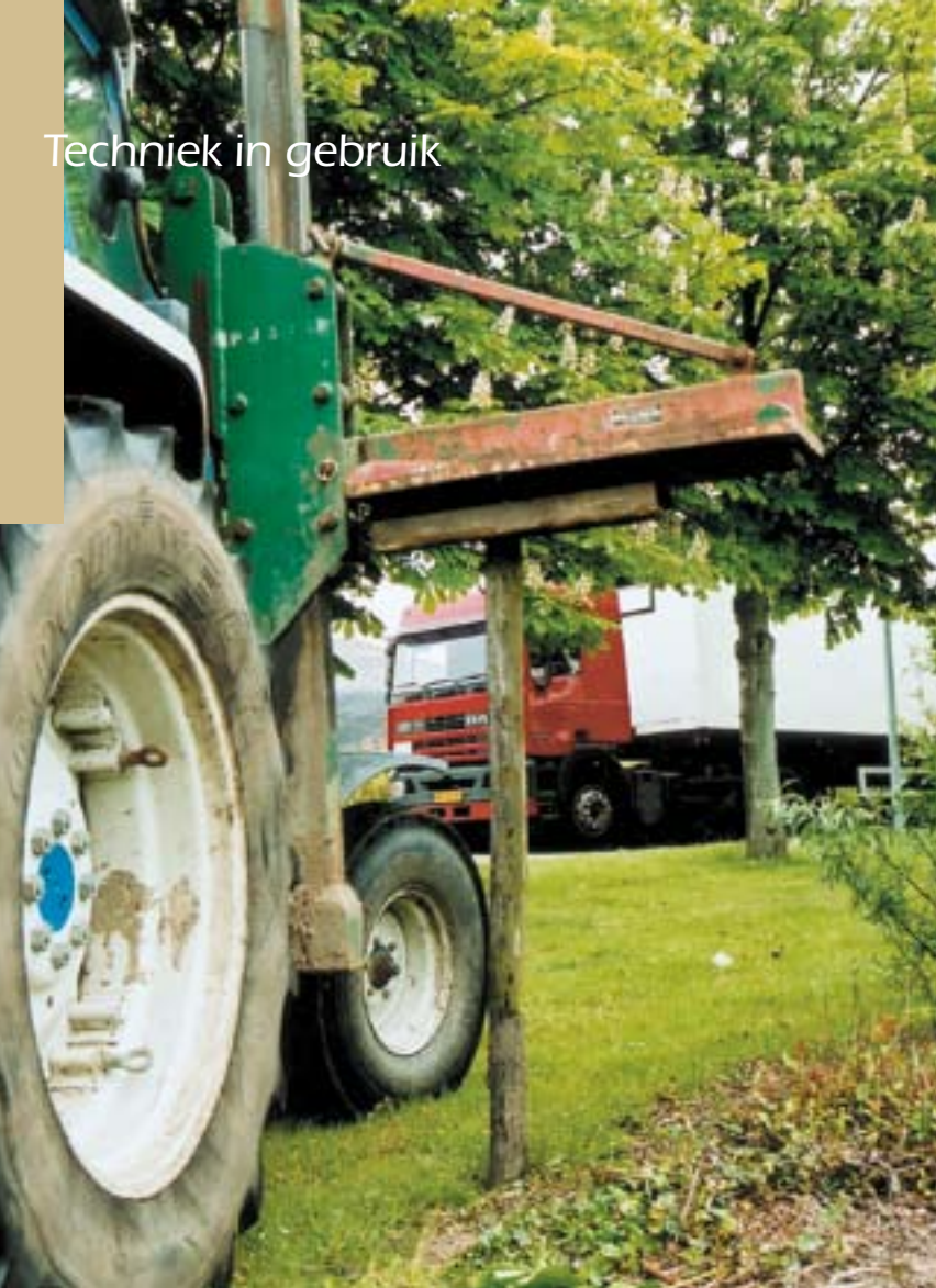
Een gepunte paal wordt hydraulisch snel in de grond gedrukt. Voor afrasteringen en boompalen kan een drukker aan de trekker prima werken. Interessant als er geen kraan beschikbaar is. Beperking is het gewicht van de trekker.
