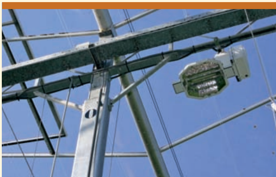
Een armschoor ondersteunt de tralie zodat die geschikt is voor hangende teeltgoten.
