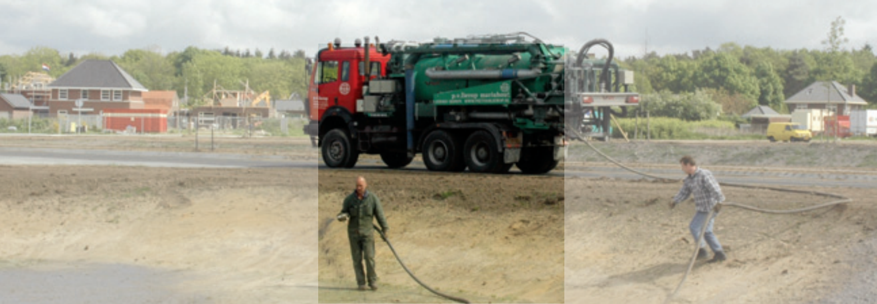
Is het zaaien of toch meer kunstschilderen? Met hydroseeding wordt gras ingezaaid in bermen en op taluds, maar ook een mengsel met kruiden wordt steeds vaker toegepast.
