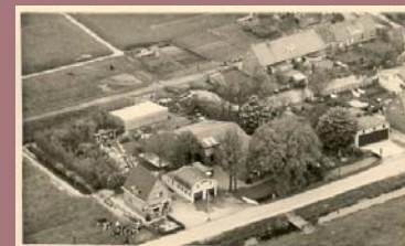
Luchtfoto uit ca. 1945 van het bedrijf in Moerkapelle.
