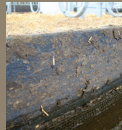
Planken van gerecycled kunststof (links) en het er over gespannen zogenoemde struisvogel-doek (rechts) houden het zand in de ligboxen.
