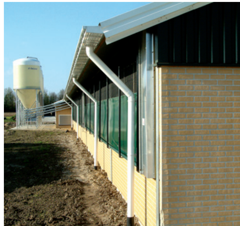
Een groot dakoverstek zorgt niet alleen voor meer schaduw en dus minder zoninstraling, doordat het regen uit de stal houdt maakt het ook een dure regensensor overbodig.
