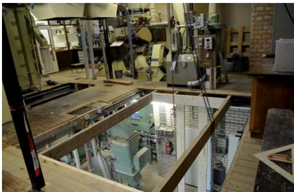
Voor de installatie van de nieuwe menger moest de vloer deels worden gesloopt.
