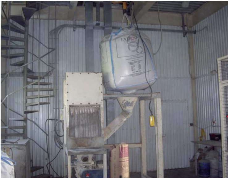
Het lossen van big bags aan het begin van de premixlijn van Fatrom.
