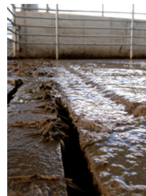
Het water loopt naar de laagste kant van de wachtruimte waarna het door de roosters in de opvangput stroomt.
