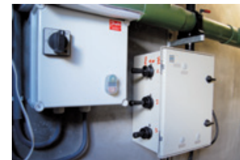
De besturingskast kent drie hendels. Daarmee bedien je de luchtzakken in de spoelkoppen. Eenmaal opgeblazen sluiten de spoelkop af zodat het water niet meer door de opening naar buiten kan stromen.
