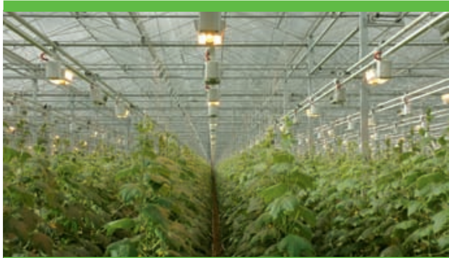
Dankzij reflectoren brengen de lampen het licht precies op de plek waar dat nodig is: bij de groeipunten en de onderste delen van de plant.
