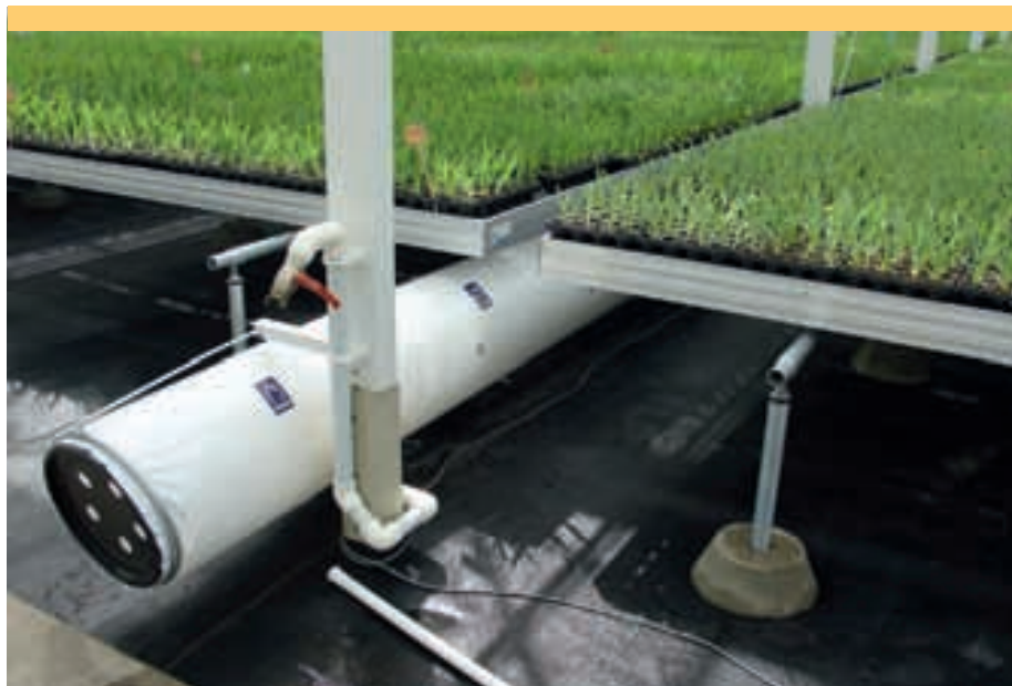
Door de luchtslangen en de ventilatoren namen de horizontale temperatuurverschillen af van 2 tot 4°C naar minder dan één graad.
