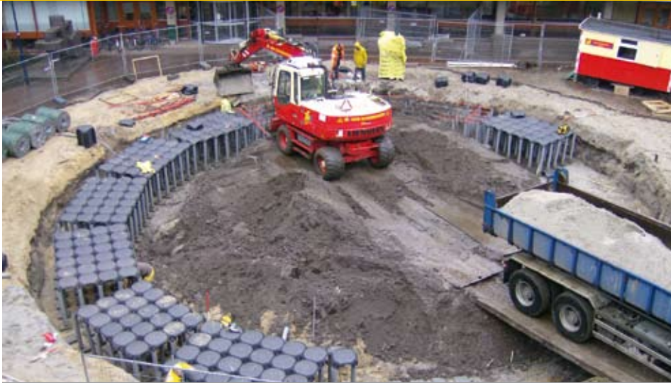
2. Op het Stadhuisplein in Amersfoort wordt de groeiplaats voor een nieuwe beukengroep van 40 jaar oud geprepareerd met het Watershell-systeem.
